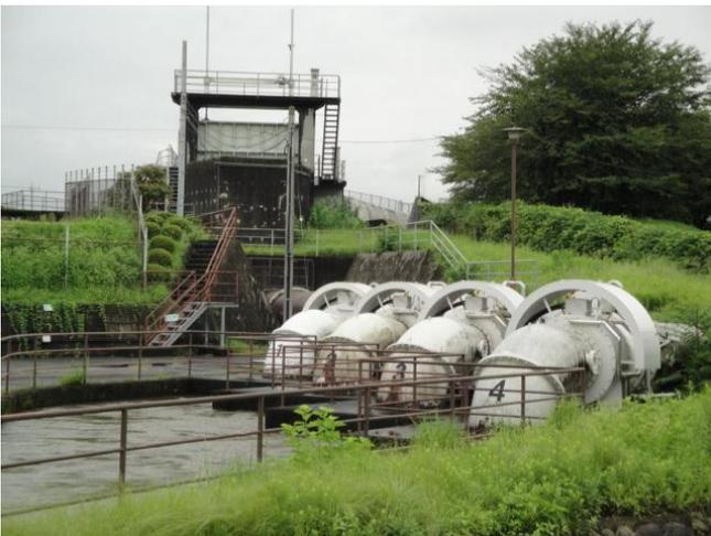
落差 7メートルで、タービンと発電機が一体になった水車発電機が 4 台設置されている。
