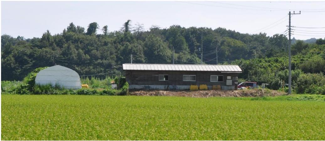
写真1 バイオマスプラント全景（右の建物が液体堆肥製造施設、左のテントはメタンガス貯蔵テント）
