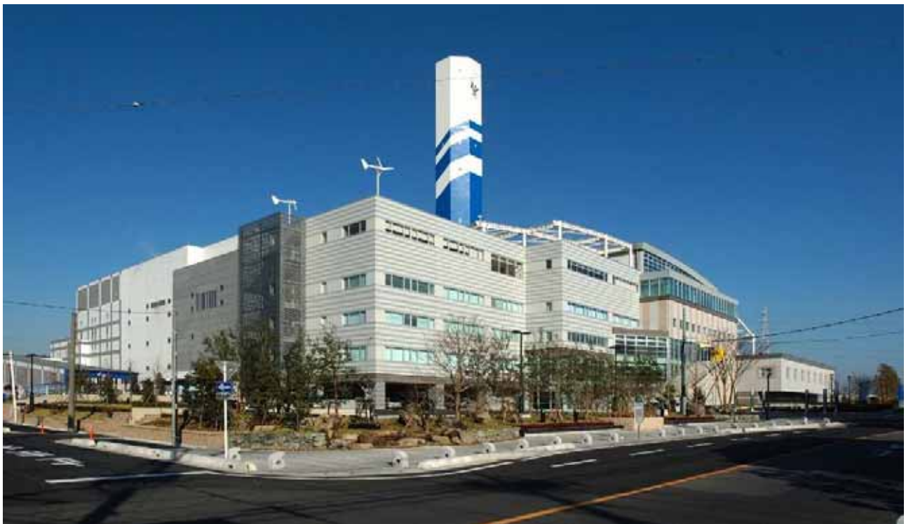
川口市朝日環境センター全景
