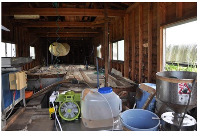
液体堆肥製造施設の内部の状況（入り口から撮影）
