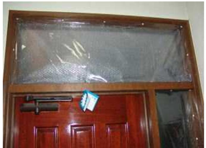
北海道のように、アクリル板を使って2重窓にできればよいのですが、とりあえず、プチプチシートと透明シートで空気の層を2重・3重に作って応急対策です。ツッパリ棒に穴をあけて、冷蔵庫の冷気の流出を防ぐ透明のカーテンのようにして、空気を遮断することもできます。
