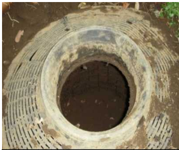
上の土を除き蓋をとった状態 (中は空っぽ)
