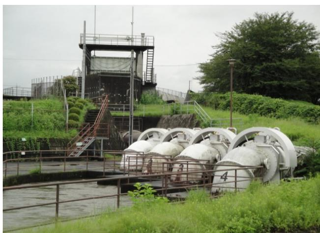
落差 7 メートルで、タービンと発電機が一体化した水車発電機が 4 台設置されている。
